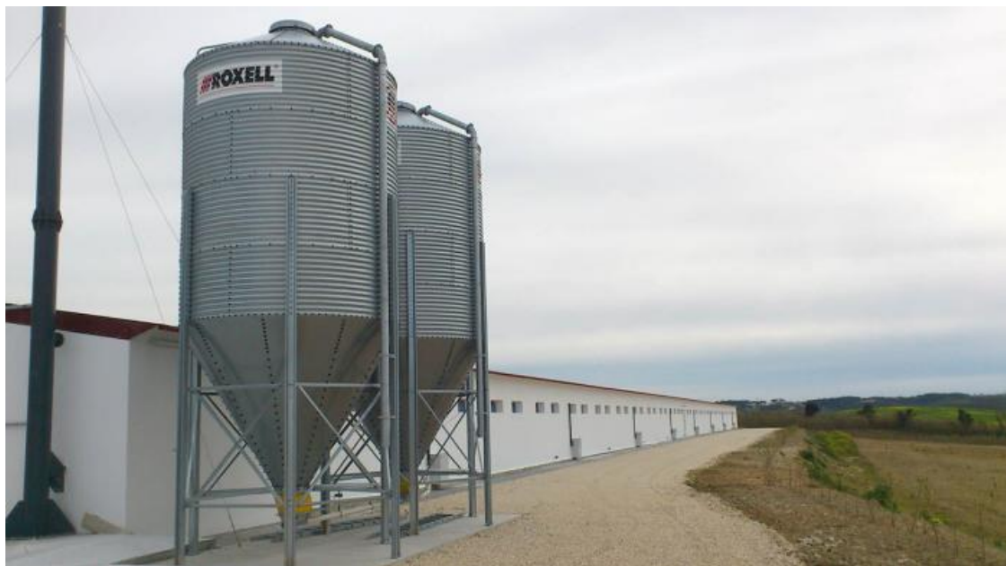
Figura 3 – Tipologia das Construções.
