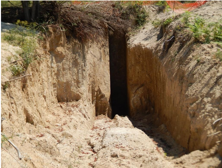
Figura 16 - Escavação em saibro no local do projecto.
